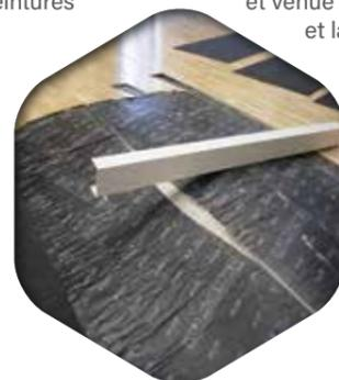
Parquet neuf gorgé d'humidité, bombé sur 10m<sup>2</sup>, remplacé intégralement
