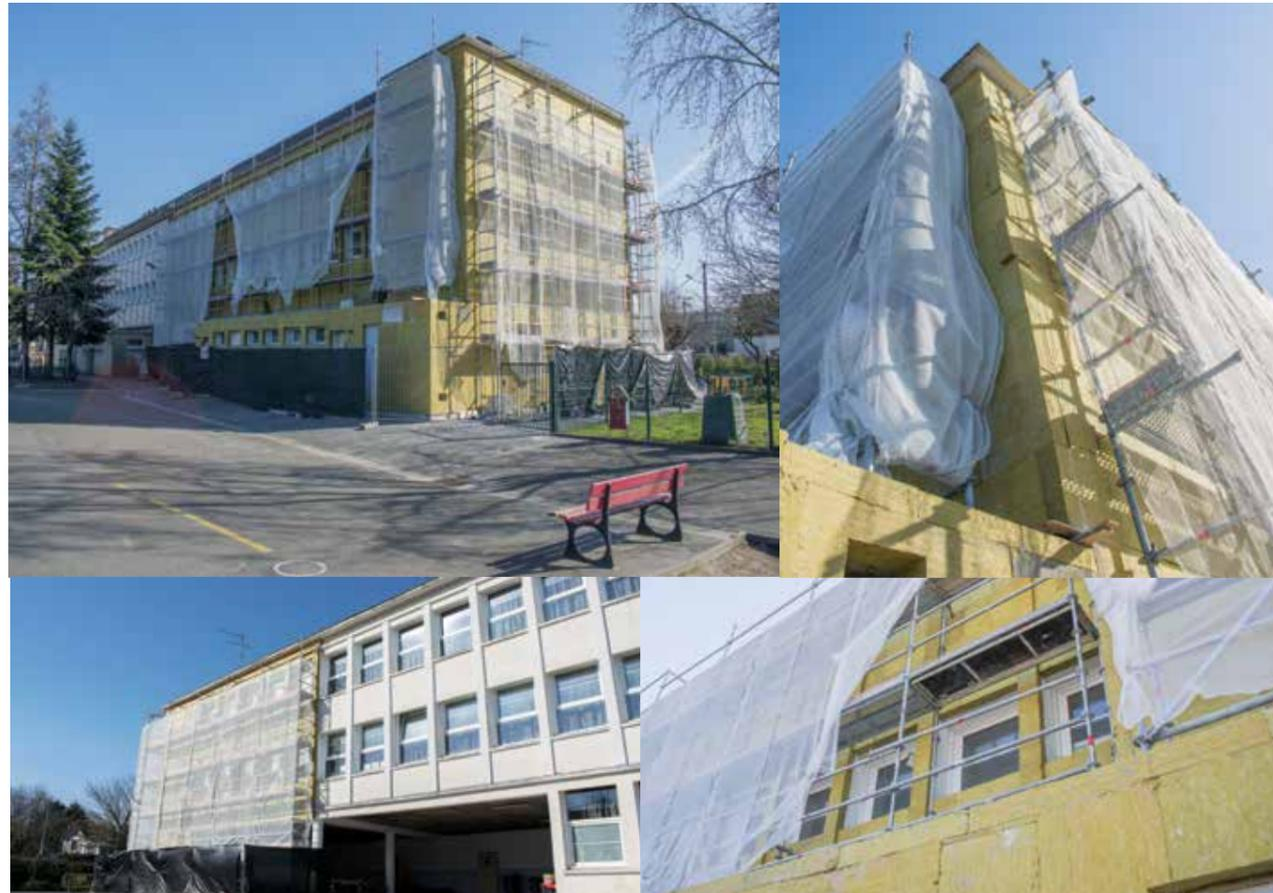
L'isolation extérieure des murs permettra, de réduire de 20 à 25 % les déperditions thermiques du bâtiment. Avec la construction d'un Accueil de Loisirs, la réhabilitation des toilettes et l'isolation thermique, le coût total estimé est de 1 724 894,50 €, dont 301 419 € avant 2023 et 24 938 € en 2024.
