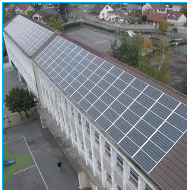
Projet exemplaire d'installation photovoltaïque en toiture du groupe scolaire des Glaisières...
